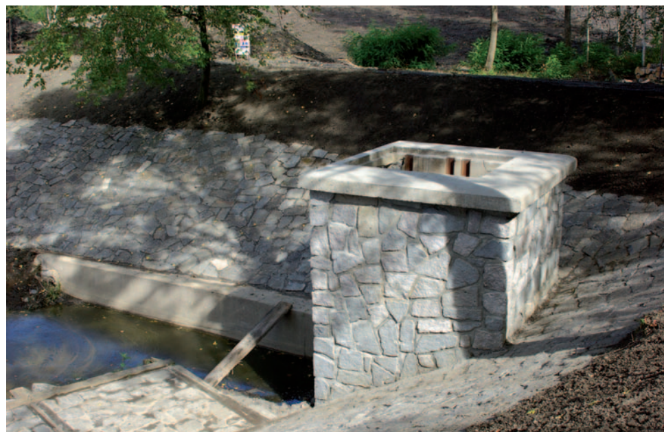
Oprava vypouštěcího zařízení
