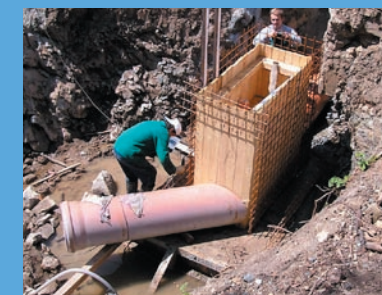
Rekonstrukce požeráku (stavidla)
