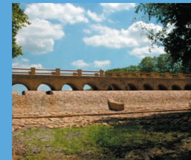
Rekonstrukce historického mostu
