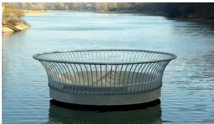
Bezpečnostní přeliv po rekonstrukci
