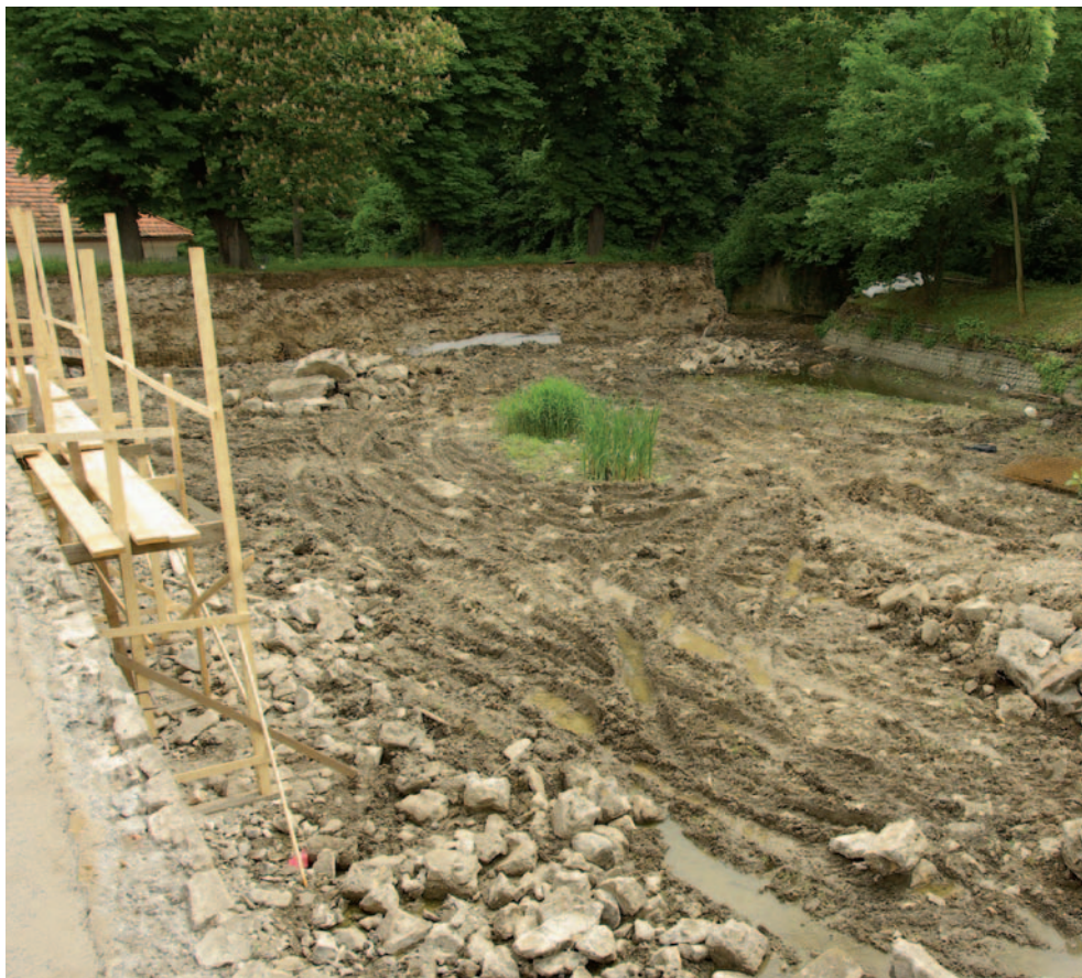
Rekonstrukce nábrežních zdí
