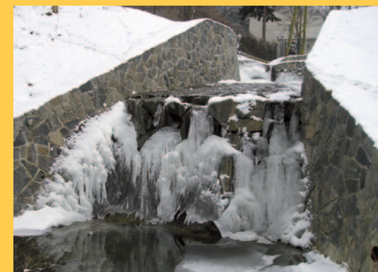
Původní betonový stupeň byl nahrazen umě- lým kamenným vodopádem
