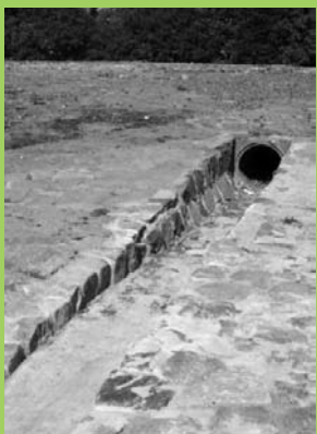
Nátok před rekonstrukcí
