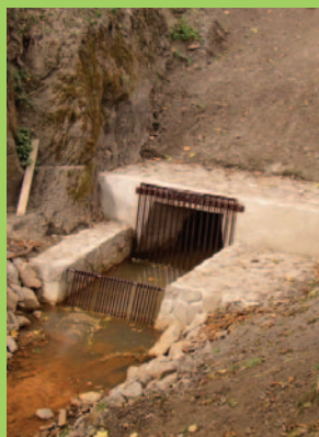
Vtok po zaklenutí
