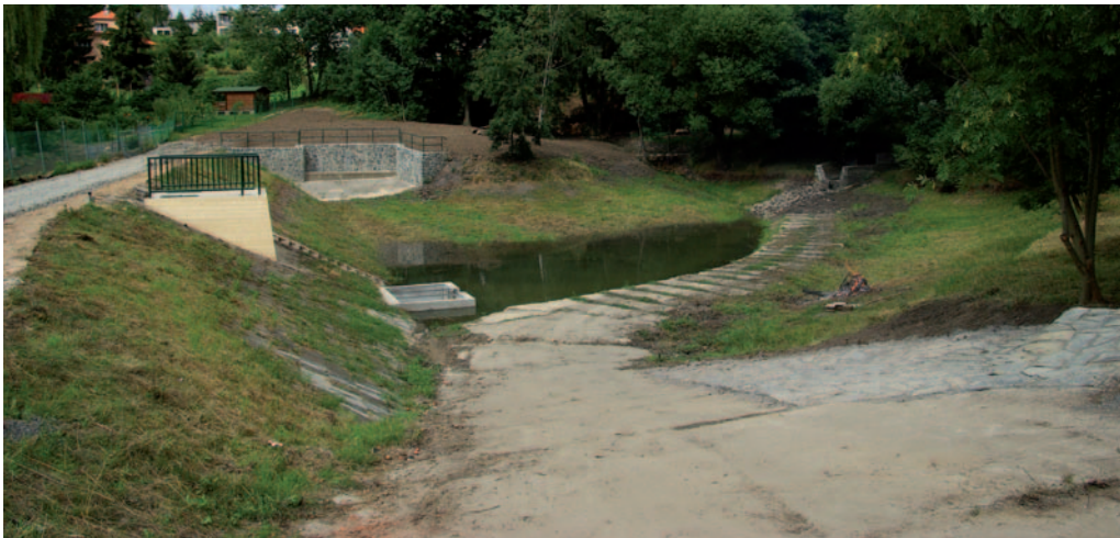
Nádrž po revitalizaci před napuštěním
