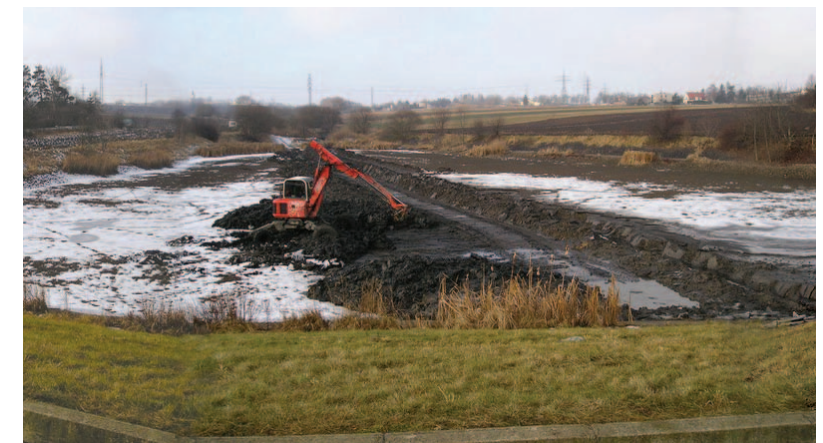
Odbahňovací práce na nádrži
