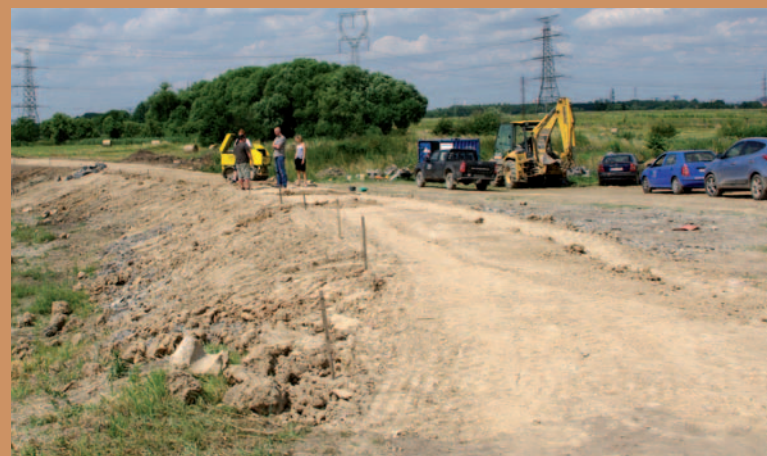
Výstavba nové hráze
