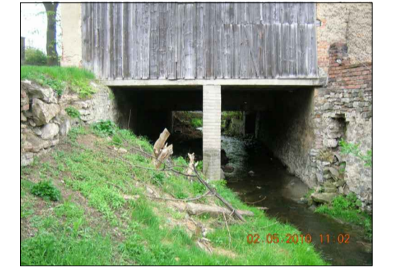
UZAVŘENÝ PROFIL POD DOMEM, d. 16,7 m PO46 - km 9.485 Q5 = 05.17 m³/s Q20 = 07.76 m³/s Q100 = 12.55 m³/s
