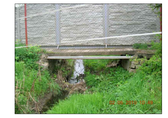
LÁVKA, š. 1,7 m PO49 - km 9.759 Q5 = 02.30 m³/s Q20 = 03.20 m³/s Q100 = 05.34 m³/s
