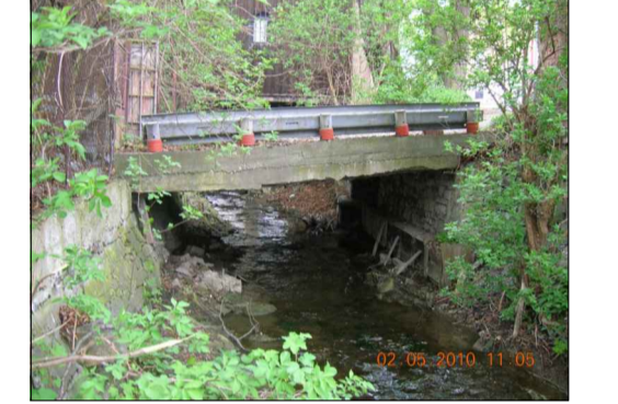
BETONOVÝ MOST, š. 4,4 m PO45 - km 9.469 Q5 = 05.17 m³/s Q20 = 07.76 m³/s Q100 = 12.55 m³/s
