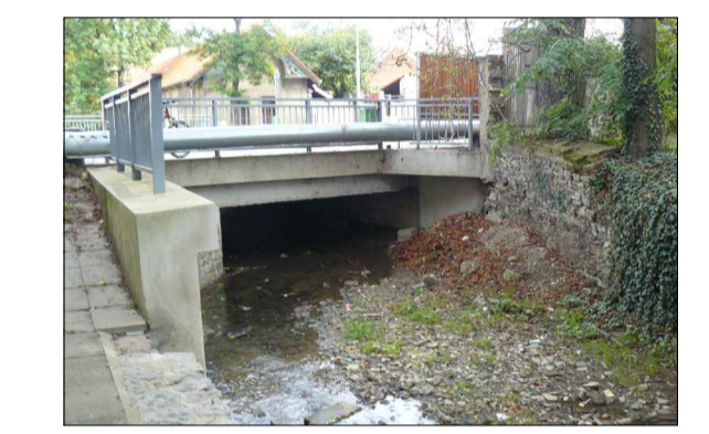
SILNIČNÍ MOST, š. 15,4 m PO47 - km 9.564 Q5 = 05.17 m³/s Q20 = 07.76 m³/s Q100 = 12.55 m³/s
